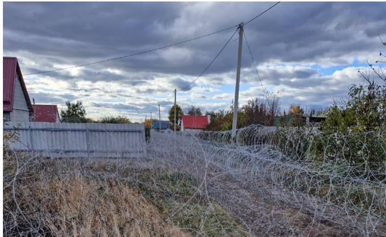
Рисунок 2.21 – Встановлення HBZ “Сгоза” для обмеження маневру піхоти противника між будинками
