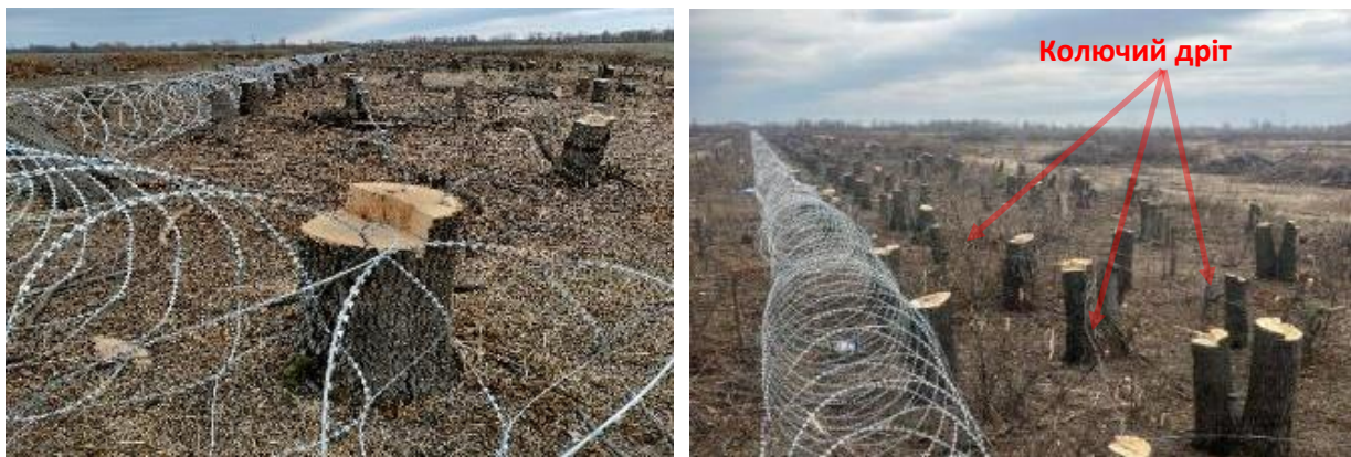
Рисунок 1.4 – Улаштування НВЗ у вирубках лісосмуг
