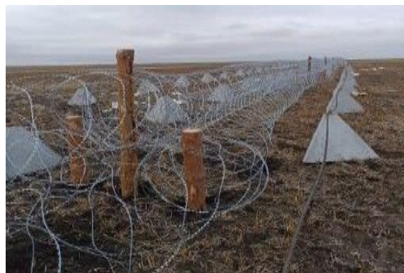
Рисунок 1.12 – Комбіноване загородження із пірамід ПЗ-1 та “Єгоза”:
