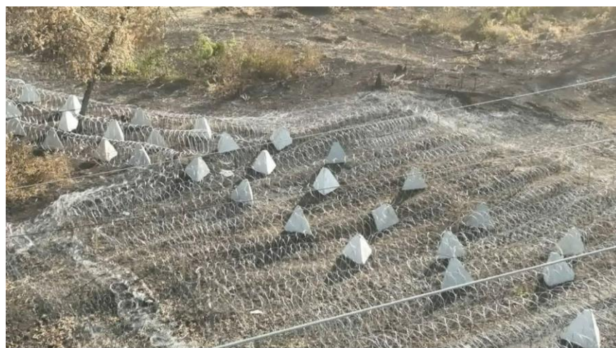
Рисунок 2.23 – Улаштування комбінованих загороджень навколо населених пунктів
