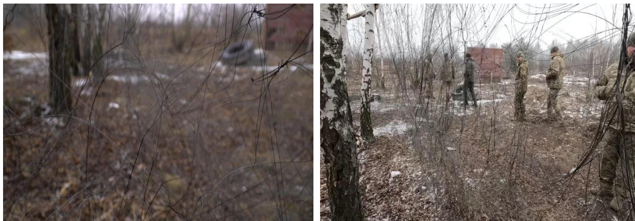
Рисунок 1.9 – Улаштування вертикальних загороджень з використанням колючого дроту або МПП (“штори”)
