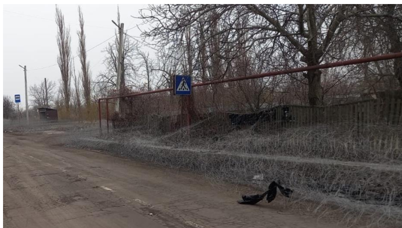
Рисунок 2.20 – Встановлення МПП з нахилом на узбіччя для унеможливлення використання противником прилеглих будівель
