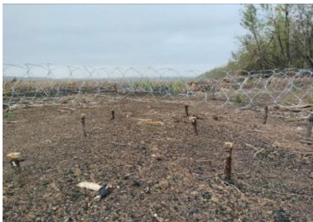
Рисунок 1.6 – Улаштування комбінованих загороджень на просіках та в лісосмугах:
