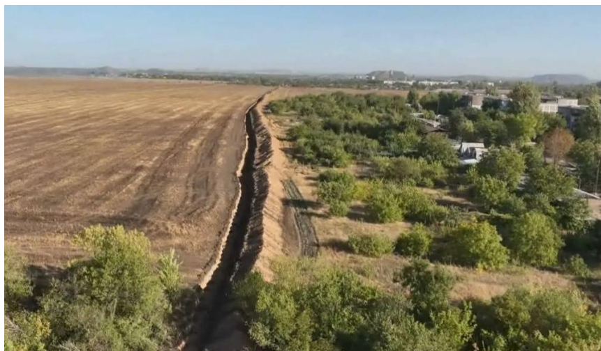
Рисунок 2.24 – Обладнання протитанкового рову на околиці населеного пункту з відвалом ґрунту у наш бік
