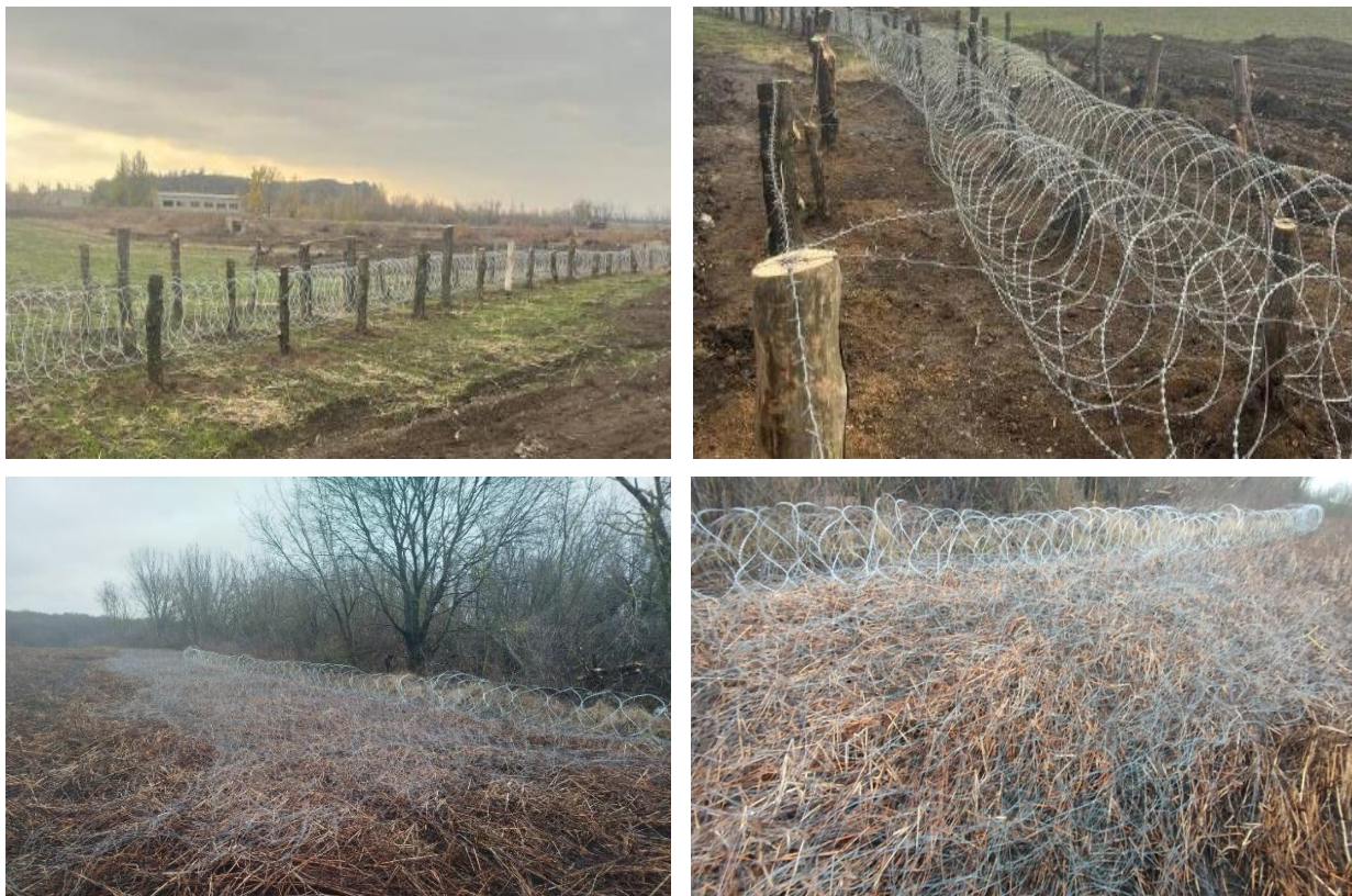
Рисунок 1.5 – Улаштування НВЗ на галявинах лісу, відкритих ділянках місцевості між лісосмугами
