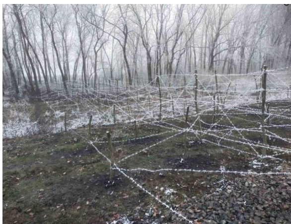
Рисунок 1.7 – Улаштування дротяної сітки на низьких та високих кілках
