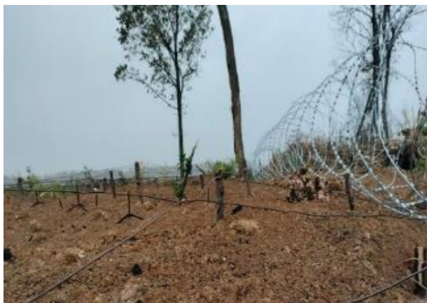
Рисунок 1.6 – Улаштування комбінованих загороджень на просіках та в лісосмугах:
