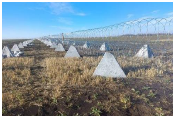
Рисунок 1.12 – Комбіноване загородження із пірамід ПЗ-1 та “Єгоза”:
