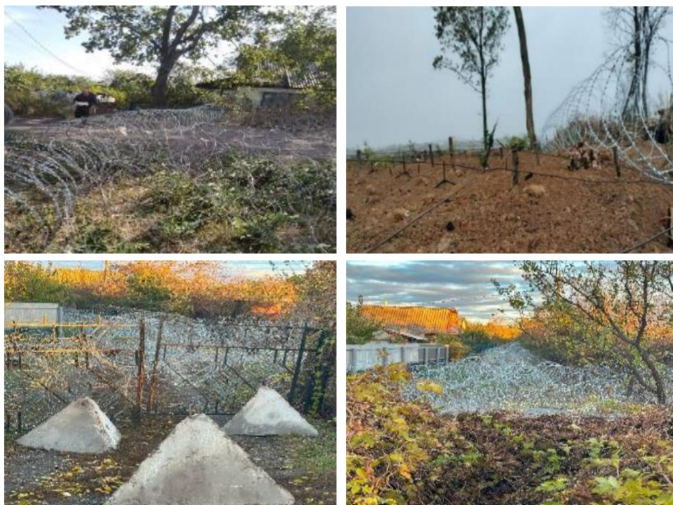
Рисунок 2.19 – Улаштування змішаних НВЗ в kill-зонах в урбанізованій місцевості
