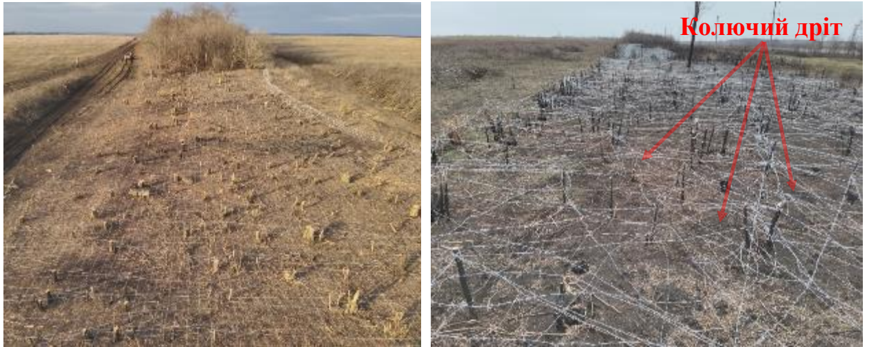
Рисунок 14 – Улаштування невибухових загороджень у вирубках лісосмуг (варіант)
