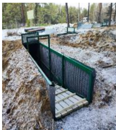
Рисунок 10 – Варіант улаштування підлог та пологих входів (виходів) типу трапів
