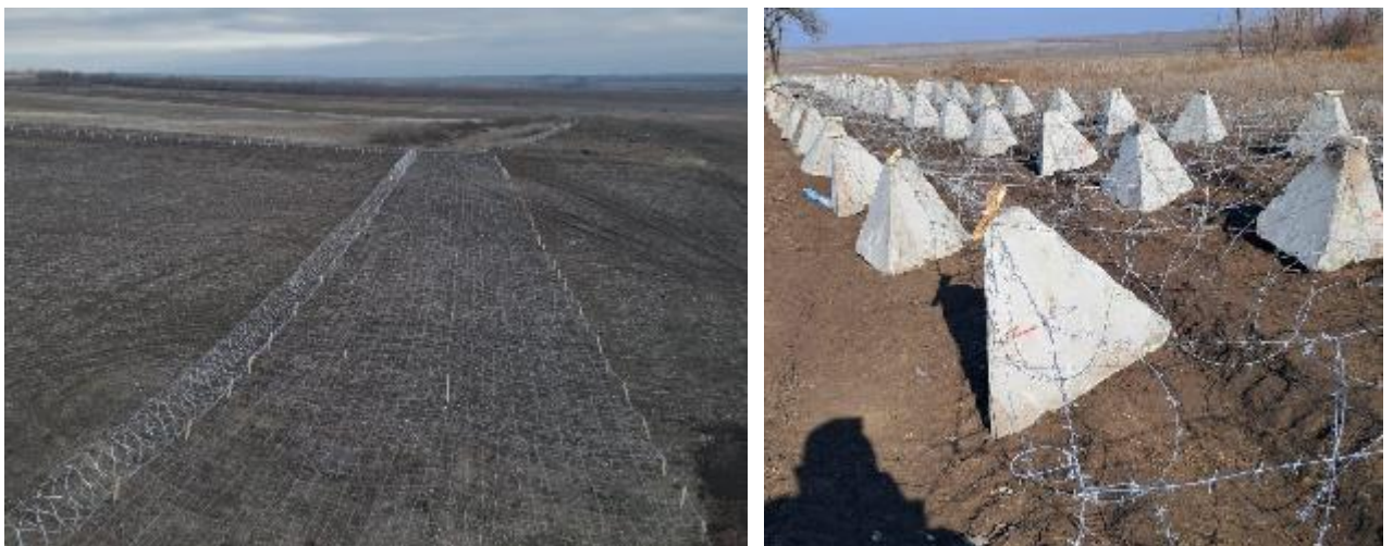
Рисунок 15 – Улаштування невибухових загороджень на відкритих ділянках місцевості (варіант)
