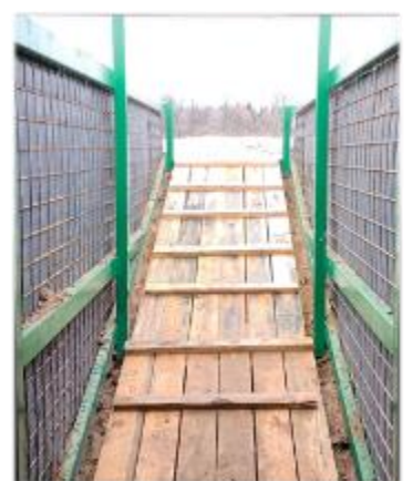
Рисунок 10 – Варіант улаштування підлог та пологих входів (виходів) типу трапів
