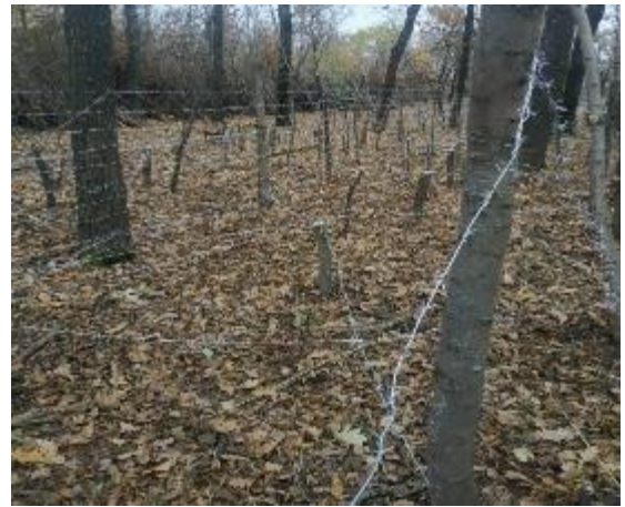
Рисунок 17 – Улаштування дротяної сітки на низьких та високих кілках (варіант)
