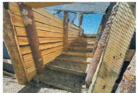
Рисунок 5 – Варіанти обладнання входів/виходів з траншей (ходів сполучення)
