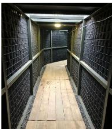
Рисунок 10 – Варіант улаштування підлог та пологих входів (виходів) типу трапів
