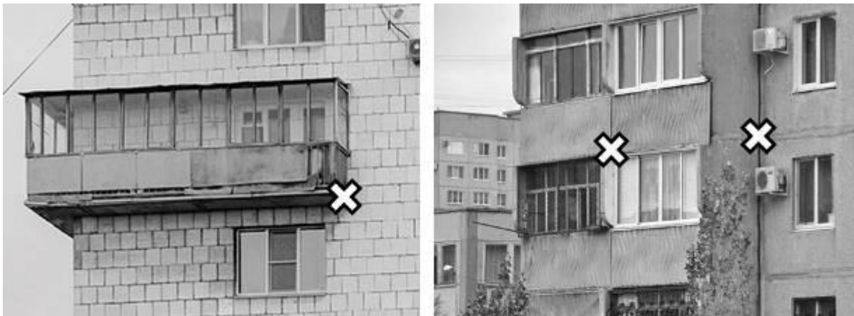
Рисунок 142 – місця технологічних кріплень та стикувальних вузлів багатоповерхових будинків.
